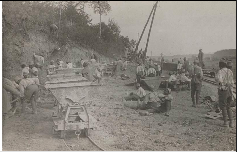
Soldats africains travaillant à la construction d'une « voie de 60 » (voie ferrée de 60 cm de largeur, utilisée pour acheminer du matériel
